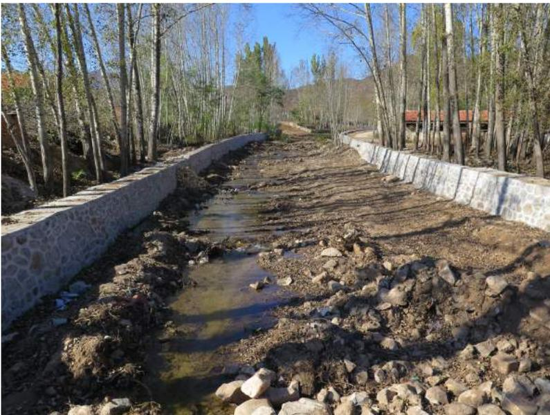
2016年，实施河北省承德市丰宁县北黄土梁护村护堤坝工程，解决135户386人汛期安全。护堤坝工程全长586延长米，全村800多人受益，可使用50余年。
